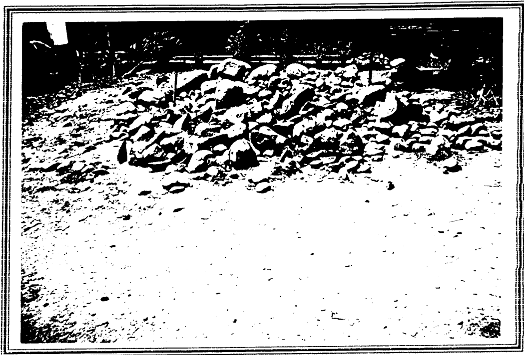
Material yang digunakan pada pekerjaan pasangan batu belah.
