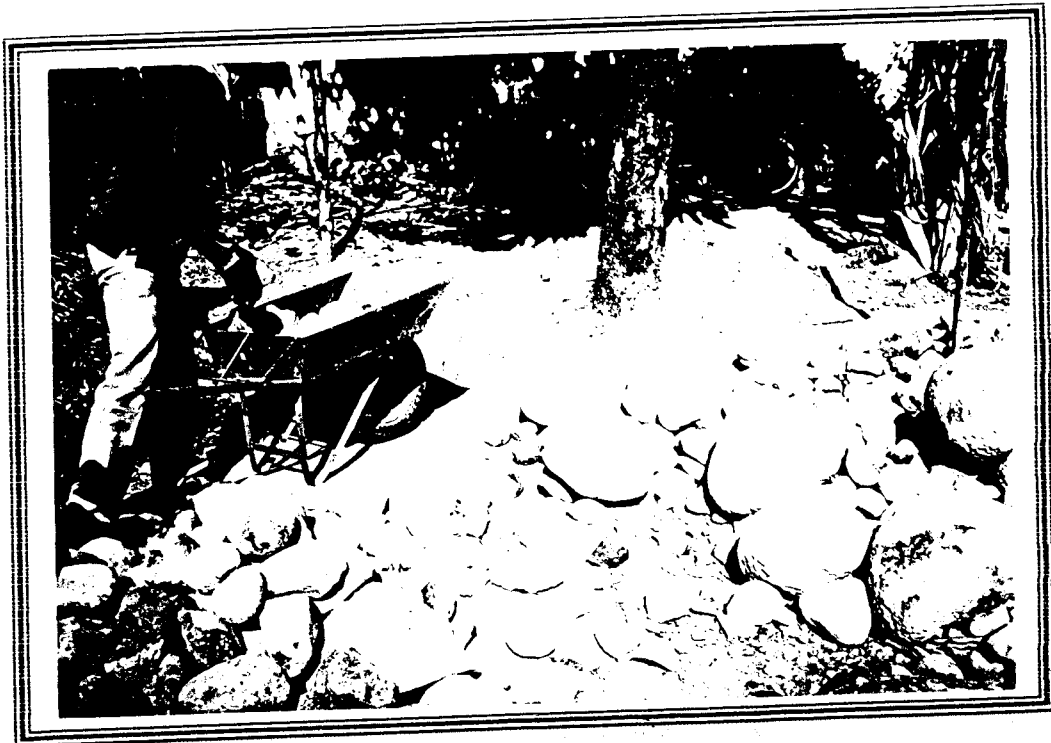
Pengangkutan batu belah ke lokasi kerja.
