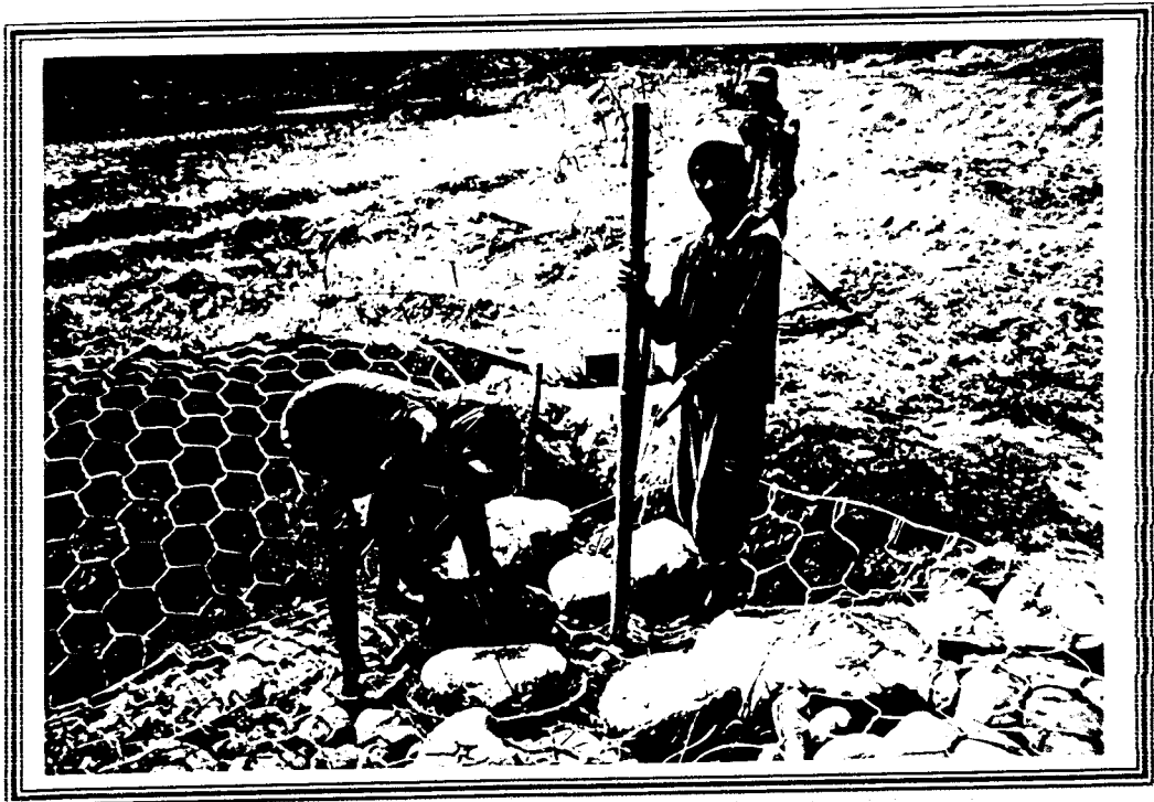
Pekerjaan pengisian material bronjong.
