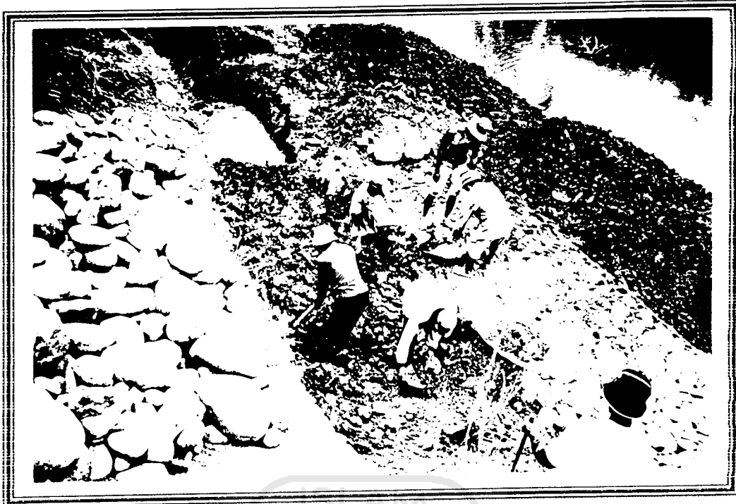
Persiapan lokasi pada pekerjaan bronjong.
