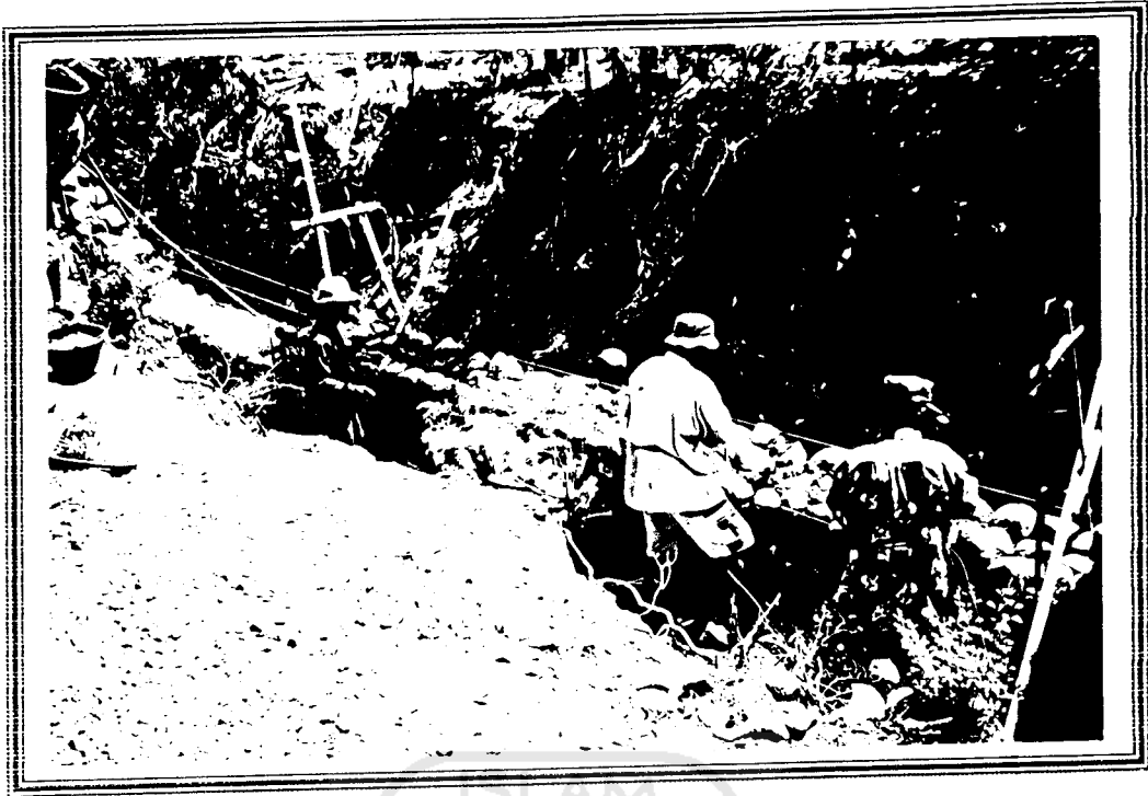
Pekerjaan pasangan batu belah pada saluran mgasi.
