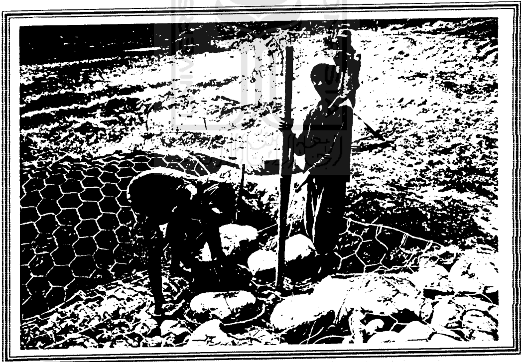
Pekerjaan pengisian material bronjong.
