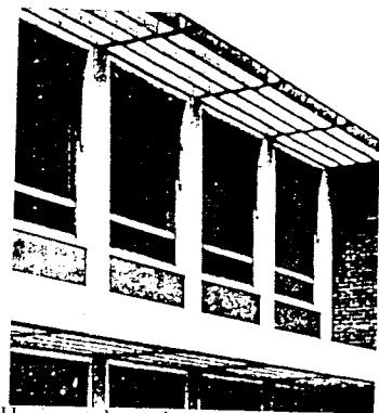
Gambar 4.12. Horizontal overhangs untuk ruang-ruang penelitian Sumber : Analisa
