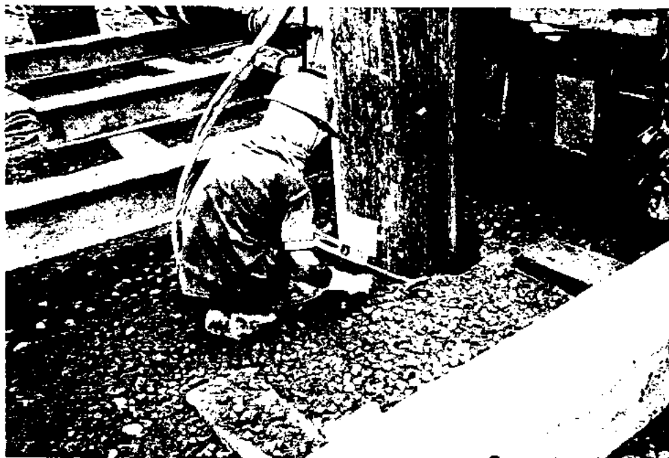
Gbr 6.8 Pengukuran penurunan pada saat final set
