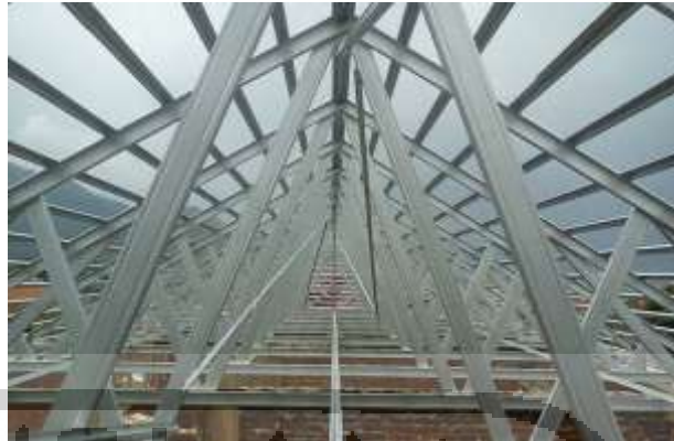
Gambar 2.1 Rangka Atap Baja Ringan
