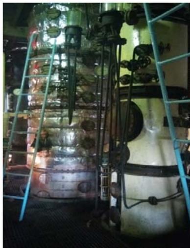
Gambar 4.7 *Rektifiser Column* (kiri) dan *Nachlop Column* (kanan)
