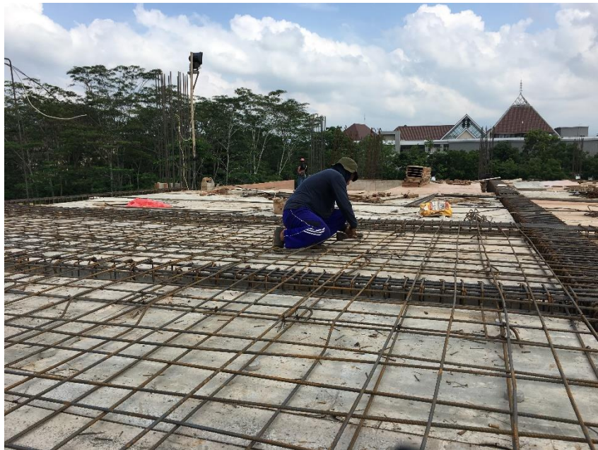
Gambar 1.3 Proses Pekerjaan Pembesian Pelat Lantai Pada Lantai 4 Proyek Pembangunan Gedung Fakultas Hukum Universitas Islam Indonesia Yogyakarta
