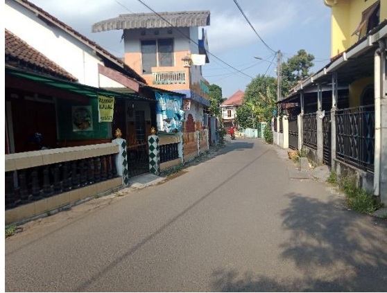
Gambar 14 : Kondisi Jalan di Dalam Kampung Mrican Sumber : Penulis
