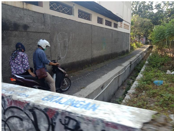
Gambar 21 : Kondisi Jalan Setapak yang Sudah Ber-paving Sumber : Penulis
