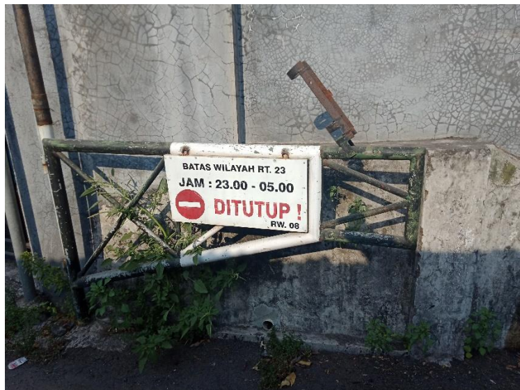
Gambar 29 : Portal dengan Penanda Waktu Ditutupnya
