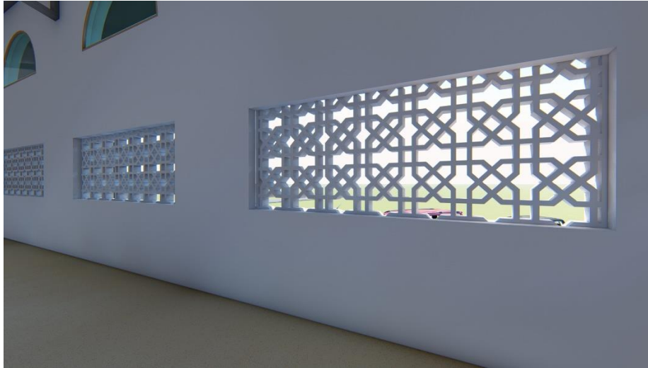
Gambar 73. Jendela hollow dan fasad sebagai rooster angin
