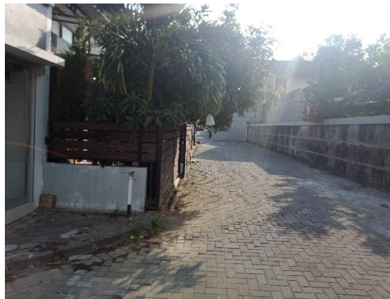
Gambar 17 : Kondisi Jalan Paving Sumber : Penulis
