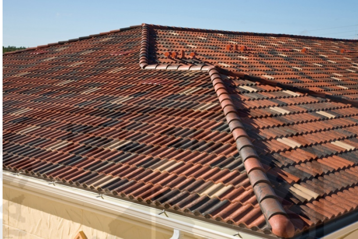
Gambar 2.10 Atap Bangunan Penangkap Air Hujan
