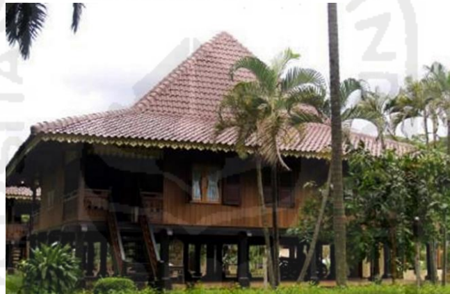
Gambar 2.21 dan Gambar 2.22 Potongan dan Eksterior Arsitektur Rumah Melayu Bubung Panjang (Sumber : Melayuonline.com)
