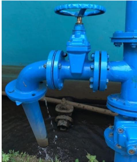
**Gambar 4.3** keran pengambilan sampel air setelah filtrasi
