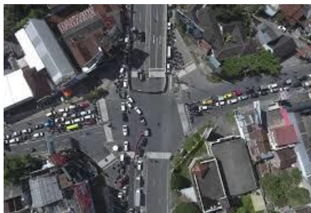
Gambar 4.7. Lokasi Perempatan kentungan sebelum adanya proyek underpass
