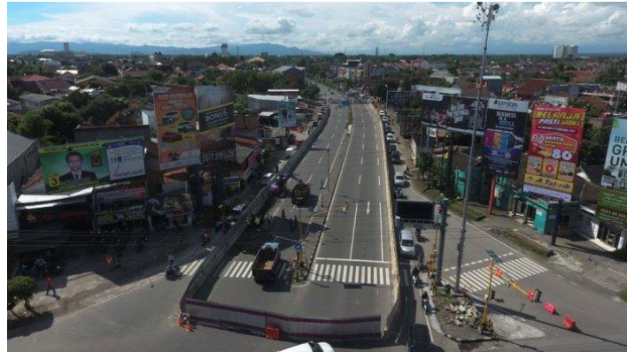
Gambar 4.8. Lokasi Perempatan Kentungan sisi barat saat proyek underpass
