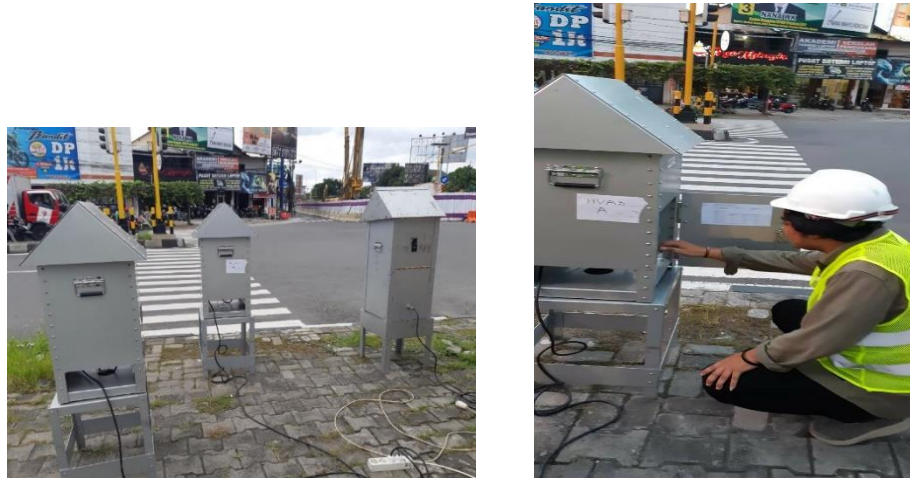
Gambar 4.3 Kondisi saat pengukuran lapangan
