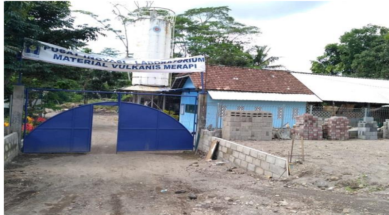
Gambar 3.2 Lokasi Pembuatan Paving Block
