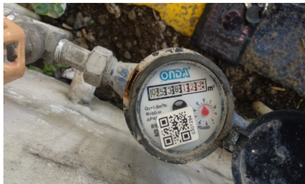
Gambar 4.55 Contoh Meter Air Pelanggan
