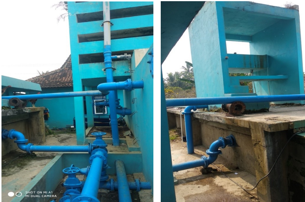
Gambar 4.3 Instalasi Godean (kiri: unit aerasi dan pipa penghubung antar unit; kanan: unit disinfeksi)
