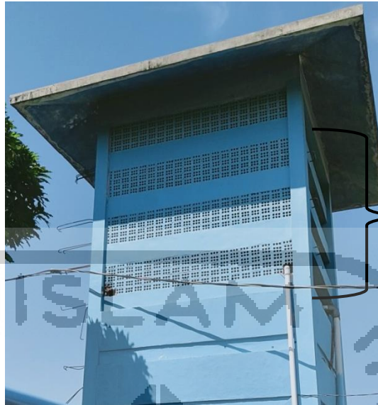
Gambar 4.18 Aerator menggunakan Multi Tray Aerator (MTA)
