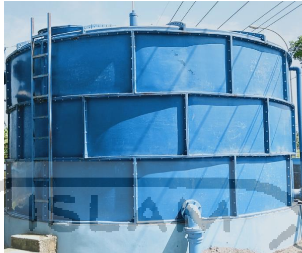
Gambar 4.21 Reservoir dengan kapasitas 50 m 3
