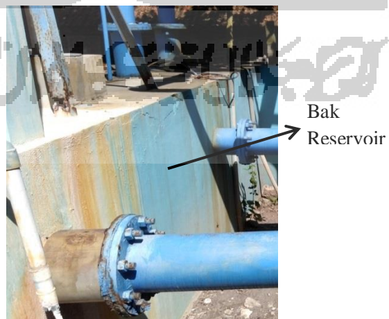
Gambar 4.12 Bak Pembubuhan menggunakan Kaporit \text{Ca}(\text{ClO})_2
