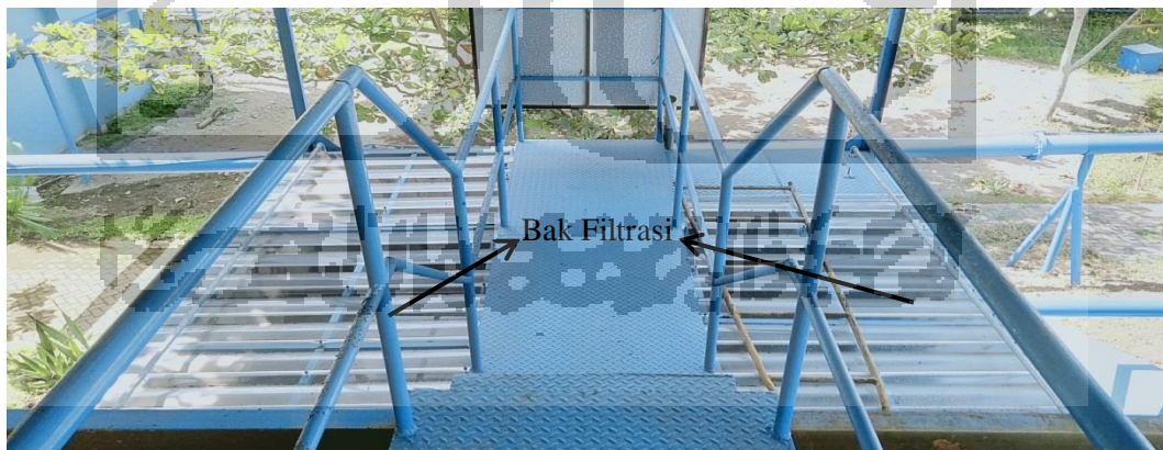
Gambar 4.36 Bak Filtrasi IPA Paket Cabang Depok Kregan
