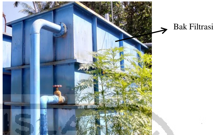
Gambar 4.11 Bak Filtrasi tidak berfungsi karena debit yang digunakan untuk melewati bak filtrasi tidak cukup
