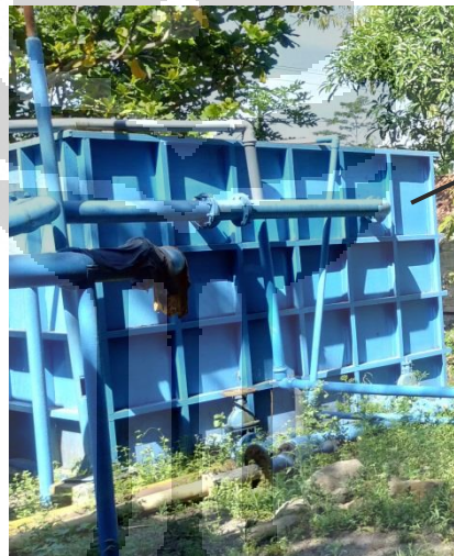
Gambar 4.10 Bak Sedimentasi tidak berfungsi karena debit yang digunakan untuk melewati bak sedimentasi tidak mencukupi
