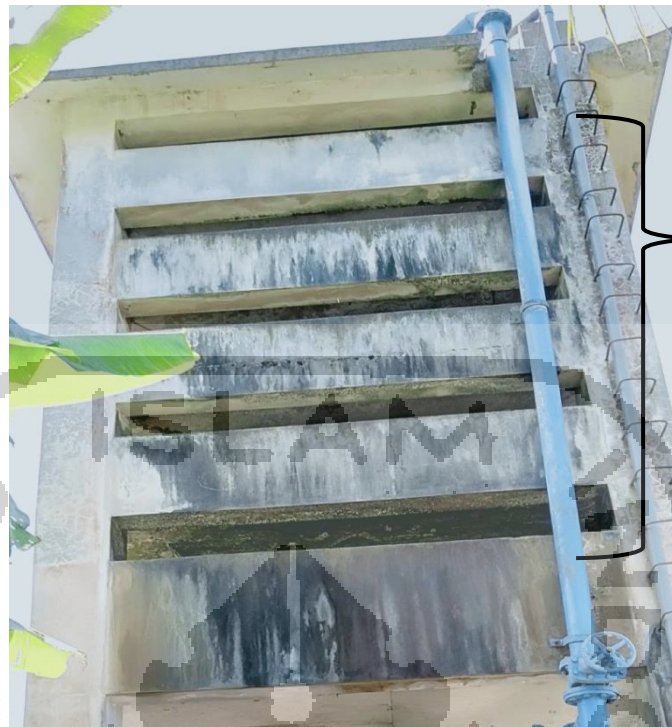
Gambar 4.26 Aerasi menggunakan Multi Tray Aerator
