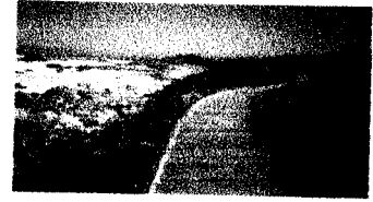
Papan pada jalan dibuat timbul pada pinggirnya untuk mencegah para pengguna jalan dari kecelakaan karena keluar dari jalur.
