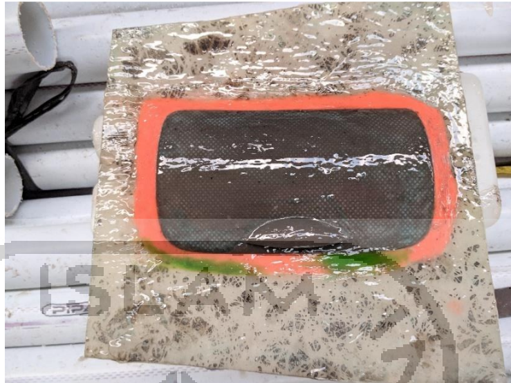
Gambar 3.21 Proses pelapisan gelcoat
