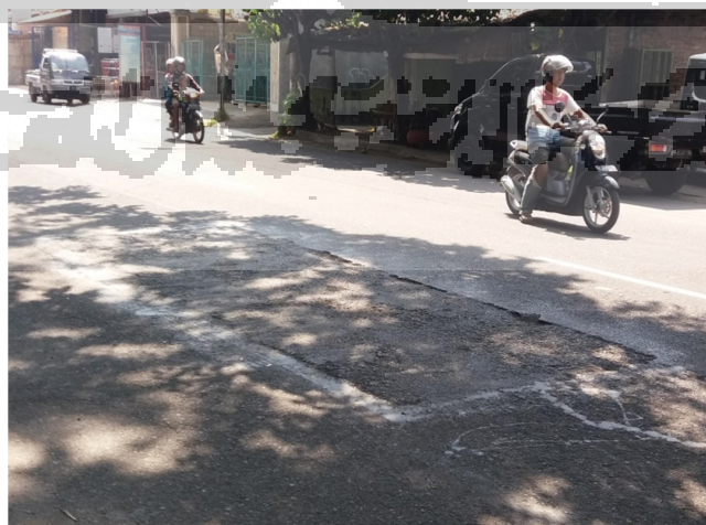
Gambar 5.12 Kondisi Penambalan Permukaan Jalan.
