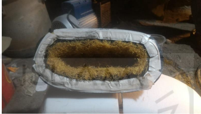
Gambar 3. 7 Pemasangan Isolasi
