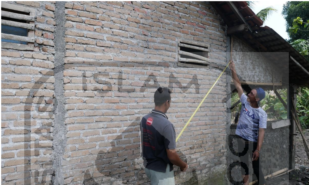
Lampiran 3 Foto dinding sebelum pekerjaan plester
