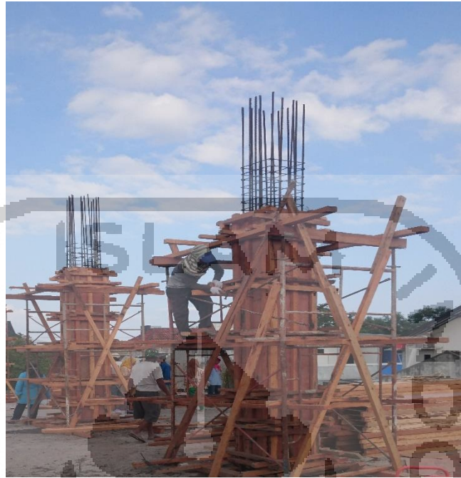
Gambar 3.2 Bekisting Kolom yang Telah Terpasang (Sumber: Pembangunan Rusun Gowok,2018)
