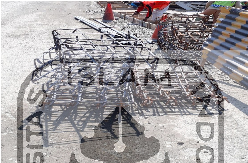
Gambar L-35.3 Pekerjaan Pembesian
