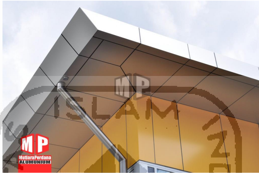
Gambar 3.2 Contoh penerapan Alumunium Composite Panel (ACP) pada bangunan
