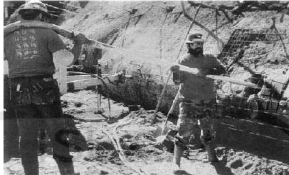
Gambar 3.14 Grouting Dengan Menggunakan Pipa Tremi
