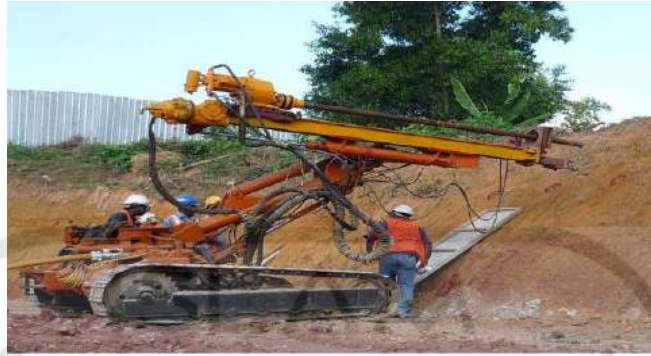
Gambar 3.13 Pengeboran Lubang Nail
