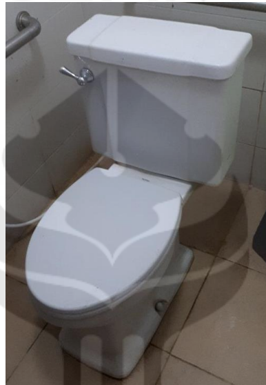
Gambar 4-7 Kloset yang telah Terpasang Engsel Hasil Re-Design
