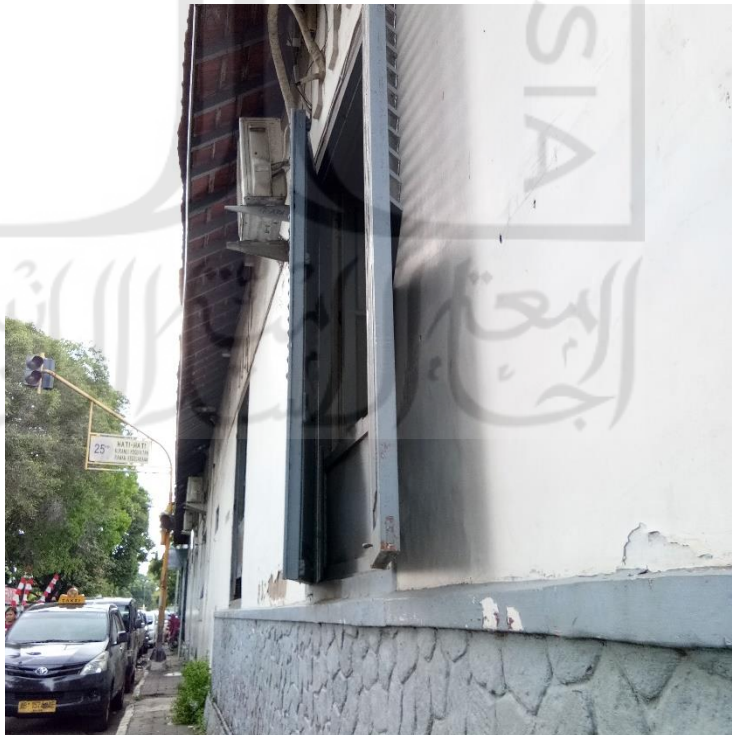
Gambar 46. Jendela pada dinding bangunan lama (Sumber: dokumen pribadi)
