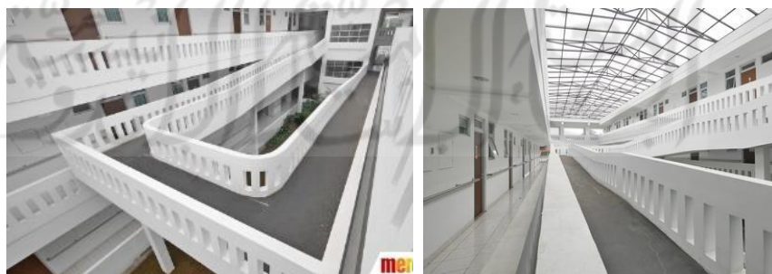
Gambar 2.16: Fasilitas Ramp Rumah Susun Cibubur
