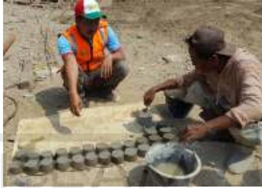
**Gambar 5.20 Pembuatan Tahu Beton (*Decking*)**
