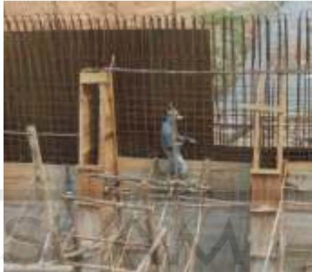
**Gambar 5.21 Perancah pada pemasangan bekisting**
