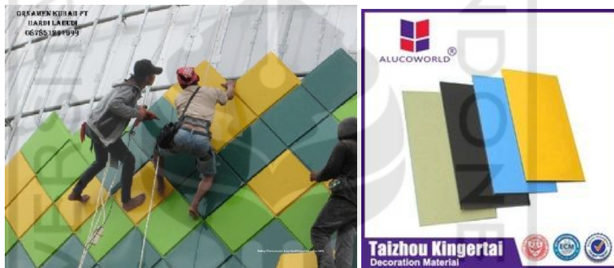
Gambar 3.33 Panel enamel komposit yang biasa diterapkan pada Kubah Sumber : https://google.image.com
