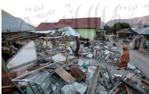
Gambar 1.1 Kondisi bangunan yang roboh di Sembalun, Lombok Timur
