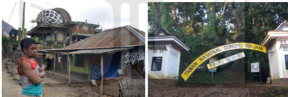
Gambar 1.14 Kondisi Bangunan di Sembalun pasca gempa
