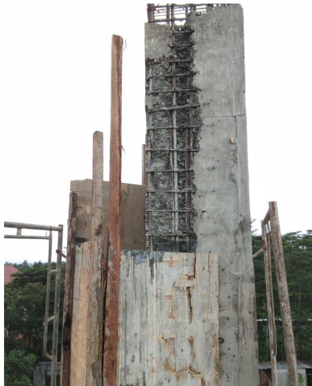
Gambar L-2.10 Kolom Setelah di cor
