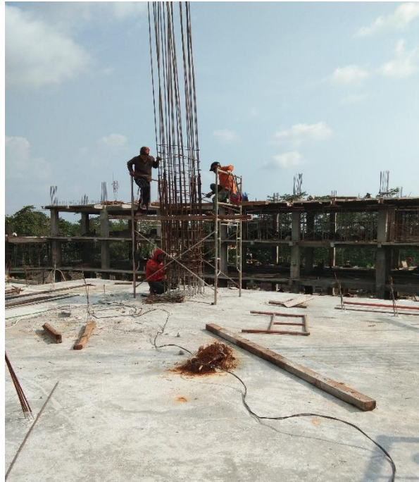
Gambar L-2.5 Pemasangan Tulangan Kolom
