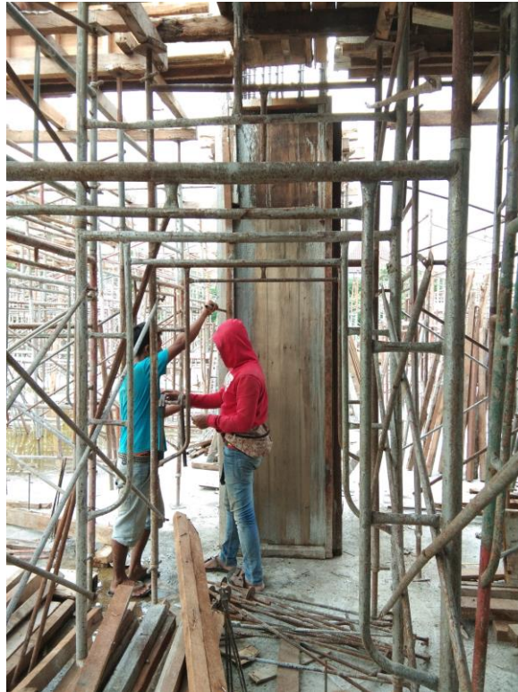
Gambar L-2.7 Pemasangan Bekisting Kolom
