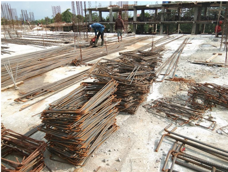
Gambar L-2.4 Tulangan di Lapangan
