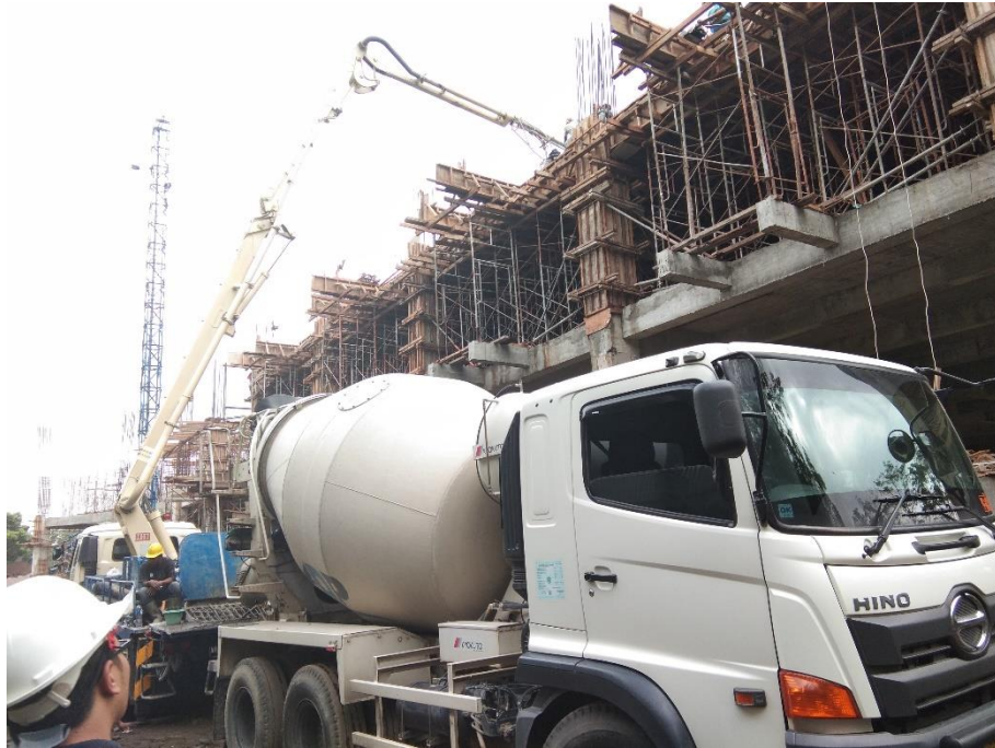
Gambar L-2.9 Pengecoran menggunakan Concrete pump
