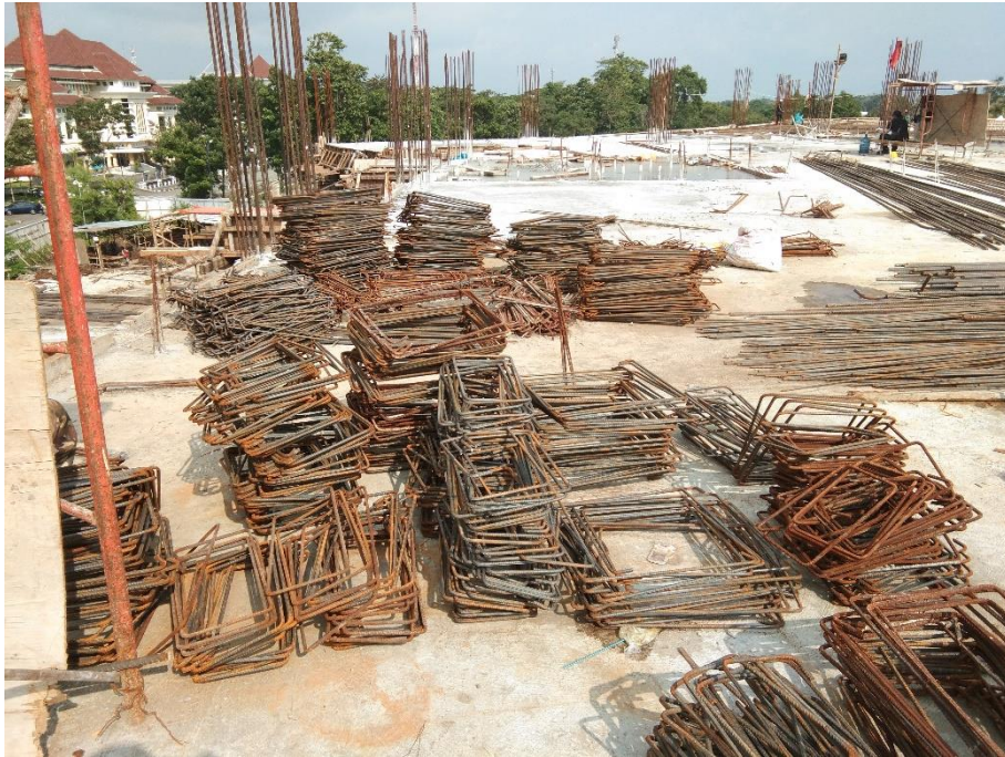
Gambar L-2.3 Tulangan di Lapangan
