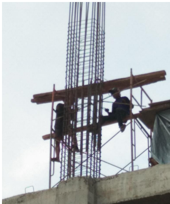
Gambar L-2.6 Pemasangan Tulangan Kolom
