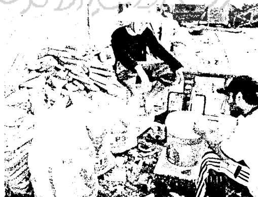
Gambar 6 Penimbangan Material Penyusun Beton
