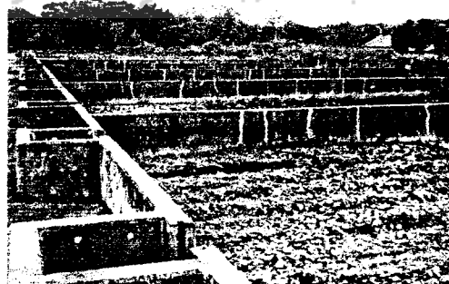
Gambar 3.2. SDB ( Sludge Drying Bed ) Pada Instalasi Pengolahan Air Limbah ( IPAL ) Domestik Sewon Bantul
