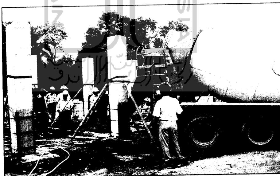
PENGECORAN GROUTING KAKI KOLOM
