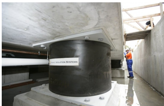
Gambar 17. Penggunaan “Base Isolation” Pada Bangunan.
