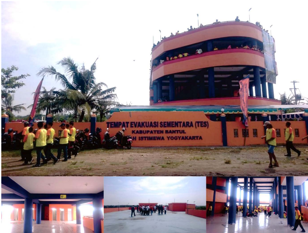
Gambar 5. TES (tempat evakuasi sementara) Pantai Kuwaru.
