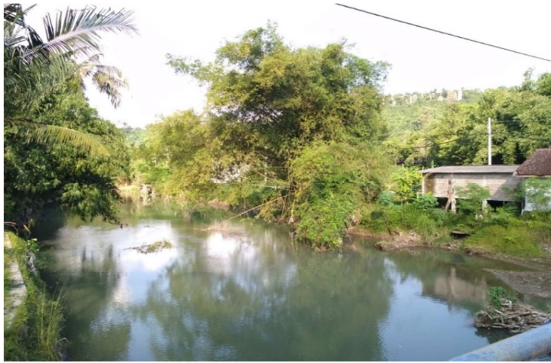
Gambar 3. 7 Jembatan Bintaran Kulon
