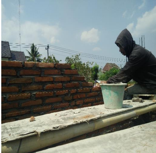
Pemasangan bata merah posisi bawah (0m - 1m)
