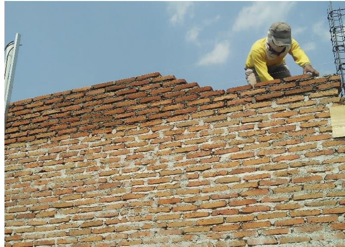
pemasangan bata merah posisi atas (2m - 3.35m)
