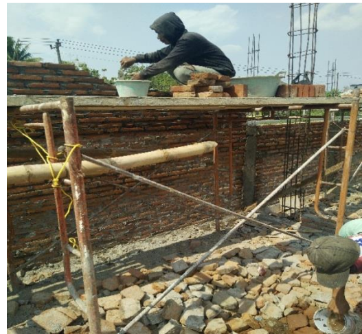
Pemasangan bata merah posisi tengah (1m - 2m)
