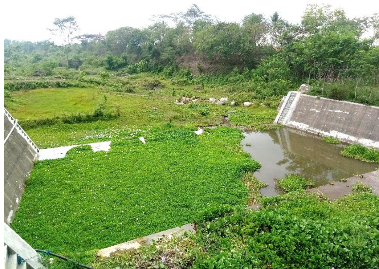
Gambar 3.7 Bendungan Air di Jembatan Sabo Bronggang
