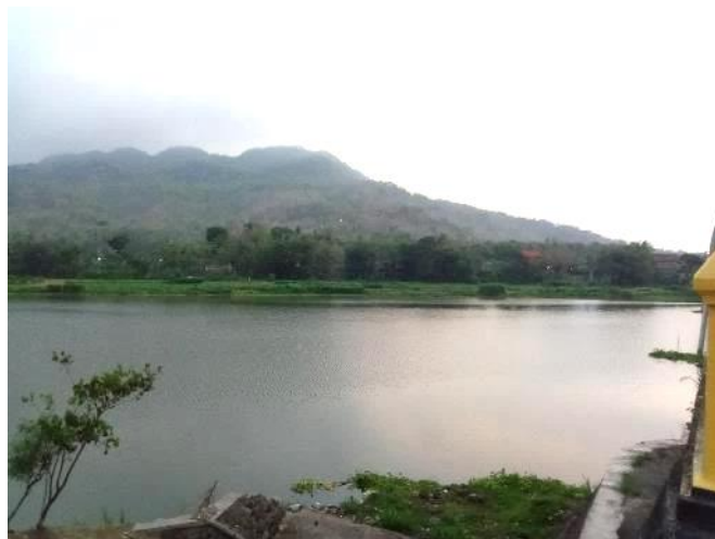
Gambar 3.17 Site 11 : Jembatan Kretek
