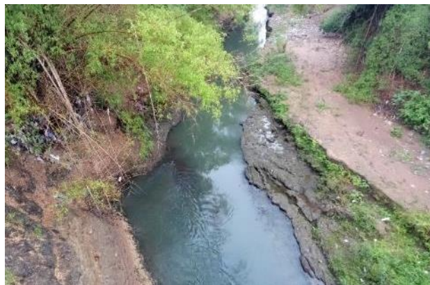
Gambar 3.10 Site 6 : Jembatan Ngablak
