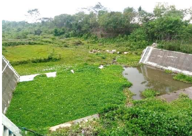
Gambar 3.5 Site 2 : Bendungan Air di Jembatan Sabo Bronggang
