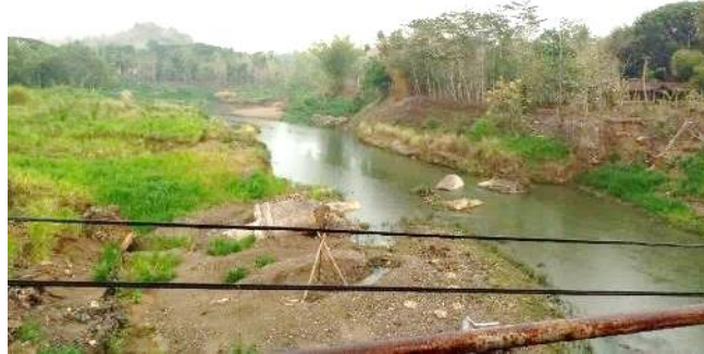
Gambar 3.16 Site 10 : Jembatan Siluk
