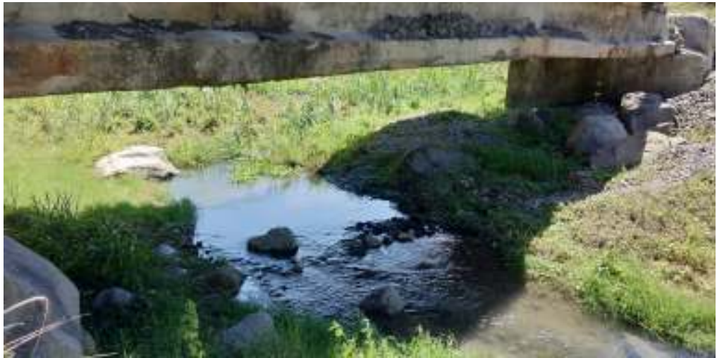
Gambar 3.3 Site 1 : Jembatan Gantung Kali Boyong
