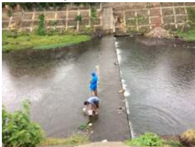
Gambar 3.8 Site 6 A : Jembatan Pogung
