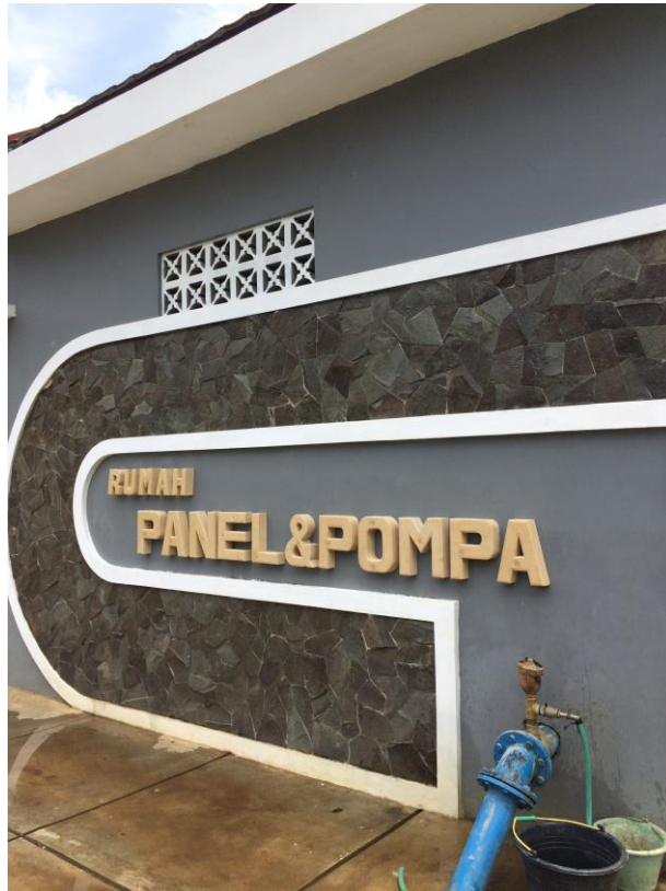
Gambar 4.26 Rumah Panel dan Pompa Milik SPAM Songgilap
