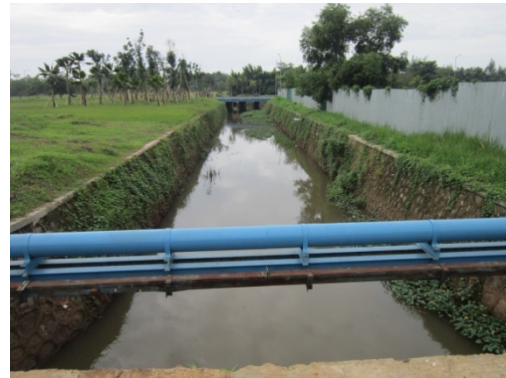
Gambar 4.24. Pipa Air Bersih
