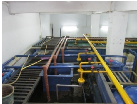
Gambar 4.27a. Pengolahan Air Daur Ulang Menggunakan Florox
