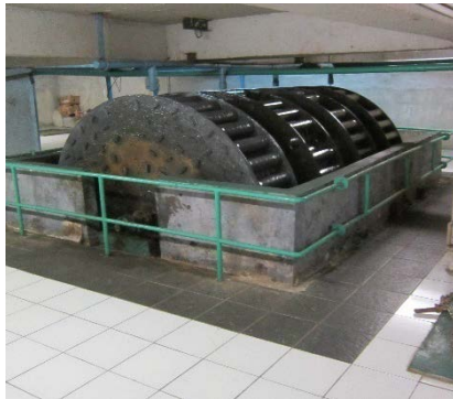
Gambar 4.25a. RBC pada Cluster Newton
