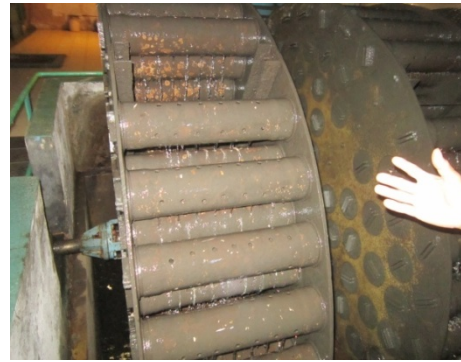
Gambar 4.25b. RBC pada Cluster Newton
