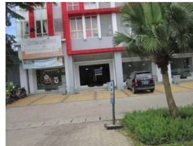
Gambar 4.7b. Penggunaan Paving Blok di Halaman Parkir Ruko
