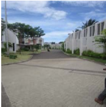
Gambar 4.48 Tembok Pembatas Cluster
