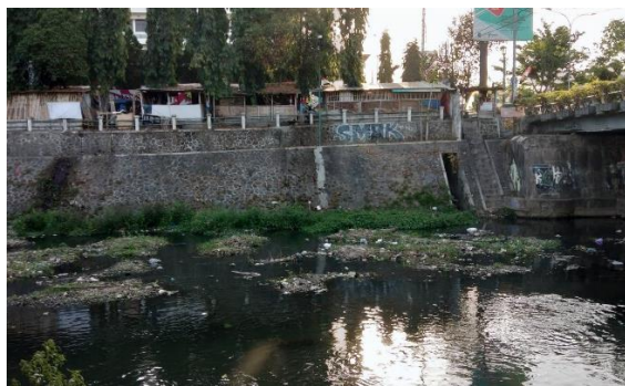
Gambar 4. 10 Kondisi Sekitar Titik C9 Sungai Code
