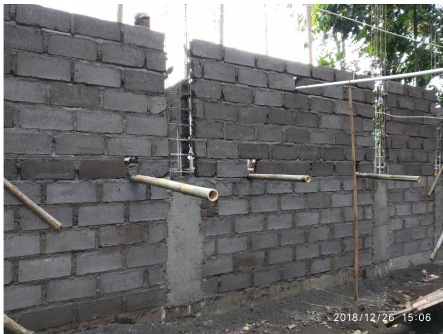
Gambar 5.6 Hasil Pemasangan Dinding Batako (Sumber: Dokumen Pribadi, 2018)
