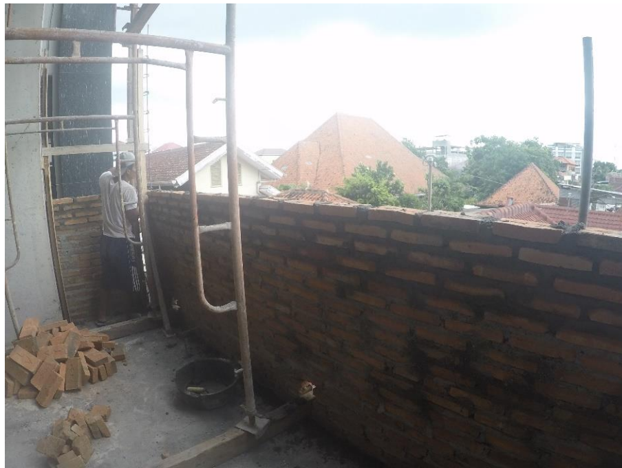
Gambar 5.4 Hasil Pemasangan Dinding Bata Merah (Sumber: Dokumen Pribadi, 2018)
