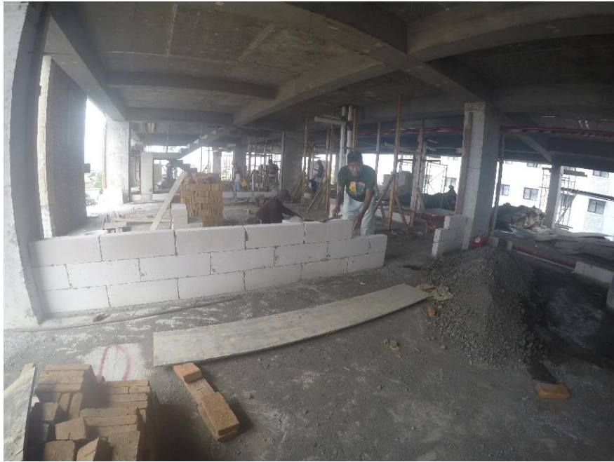
Gambar 5.5 Hasil Pemasangan Dinding Bata Ringan (Sumber: Dokumen Pribadi, 2018)
