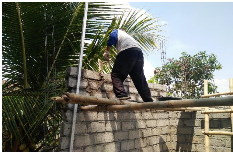
pemasangan bata merah posisi atas (2m - 3.3m)
