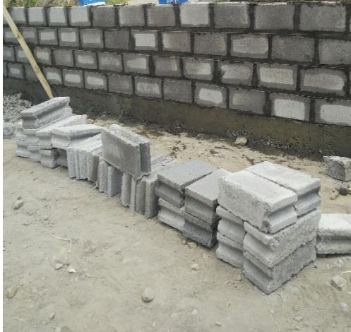
Pemasangan batako posisi bawah (0m - 1m)
