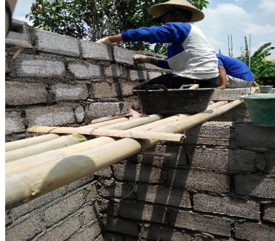
Pemasangan bata merah posisi tengah (1m - 2m)
