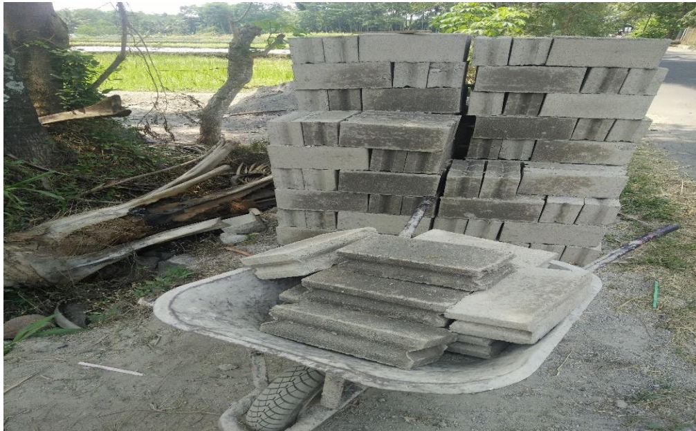
Gambar 5.3 Pengangkutan dan Penumpukan Batako
