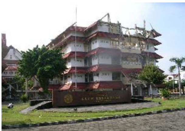
Gambar 1. 1 Gedung fasilitas pendidikan yang runtuh akibat gempa Yogyakarta tahun 2006
