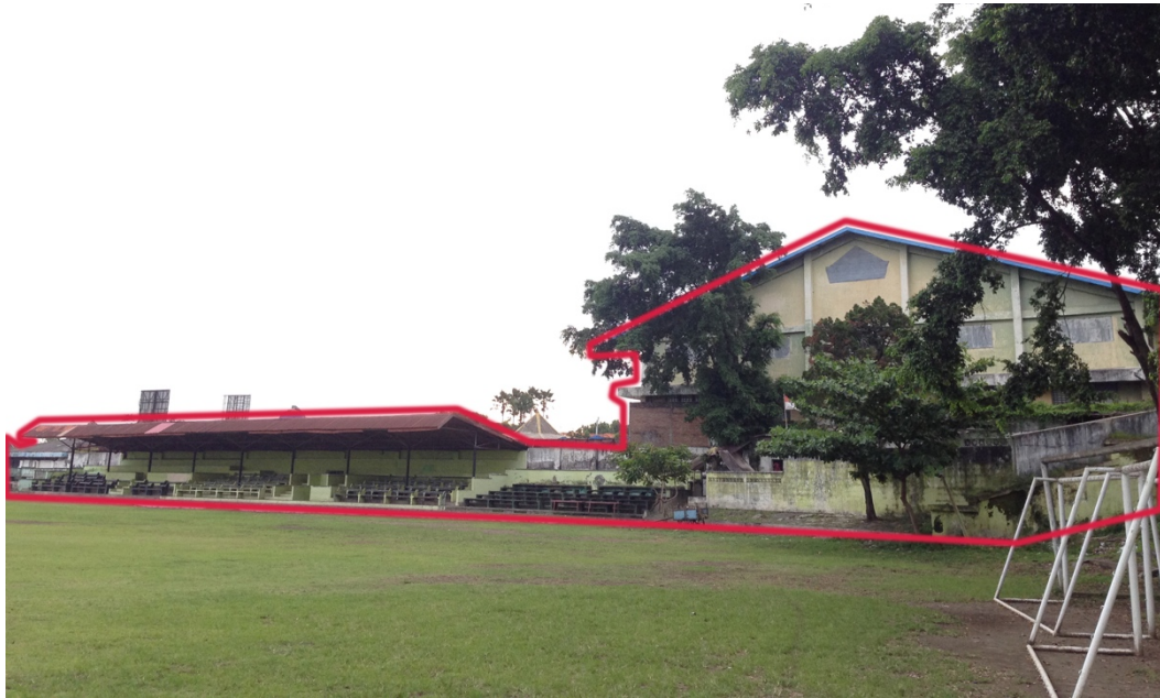
Gambar 102 Kondisi Bangunan Eksisting Sumber: Penulis, 2019
