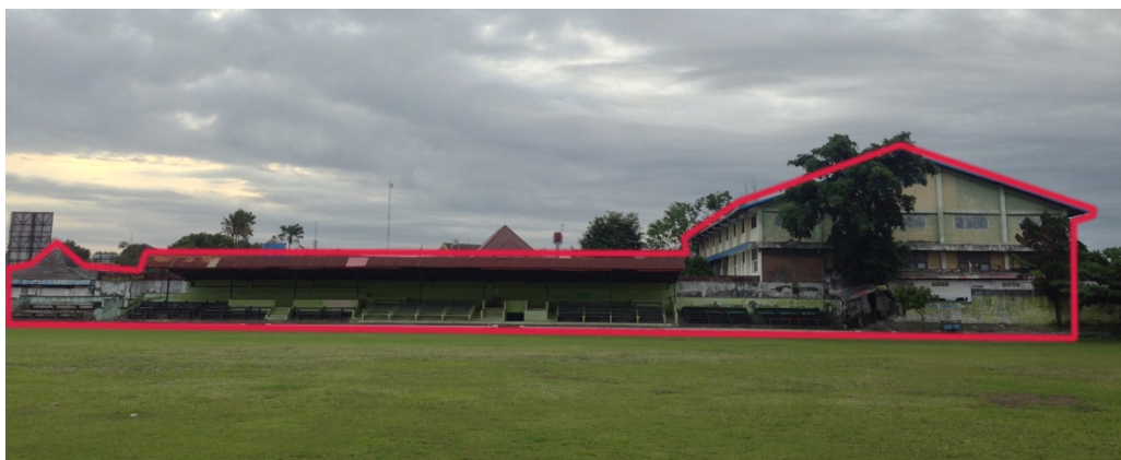
Gambar 107 Selubung Bangunan Eksisting Sumber: Penulis, 2019
