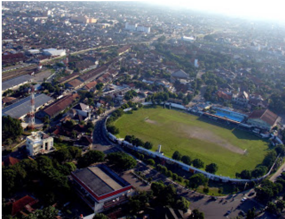
Gambar 10 Foto Aerial Stadion Kridosono, Yogyakarta
